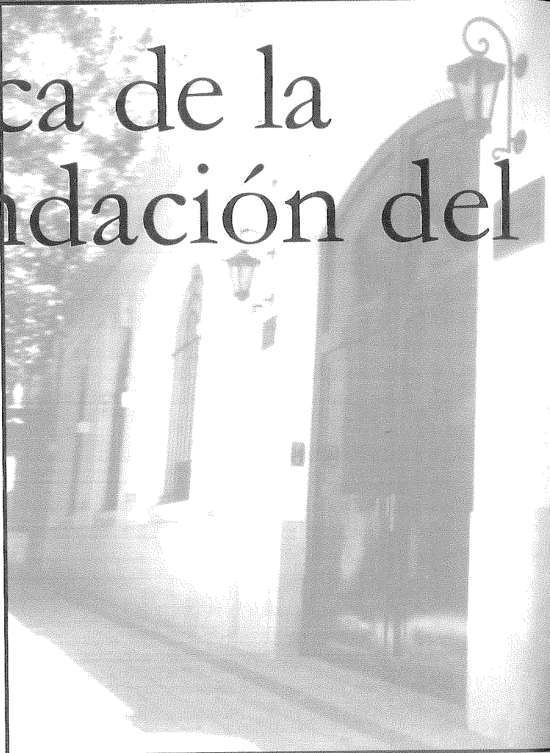
Edificio del C.A.B.A. en 51N° 1285 de La Plata
