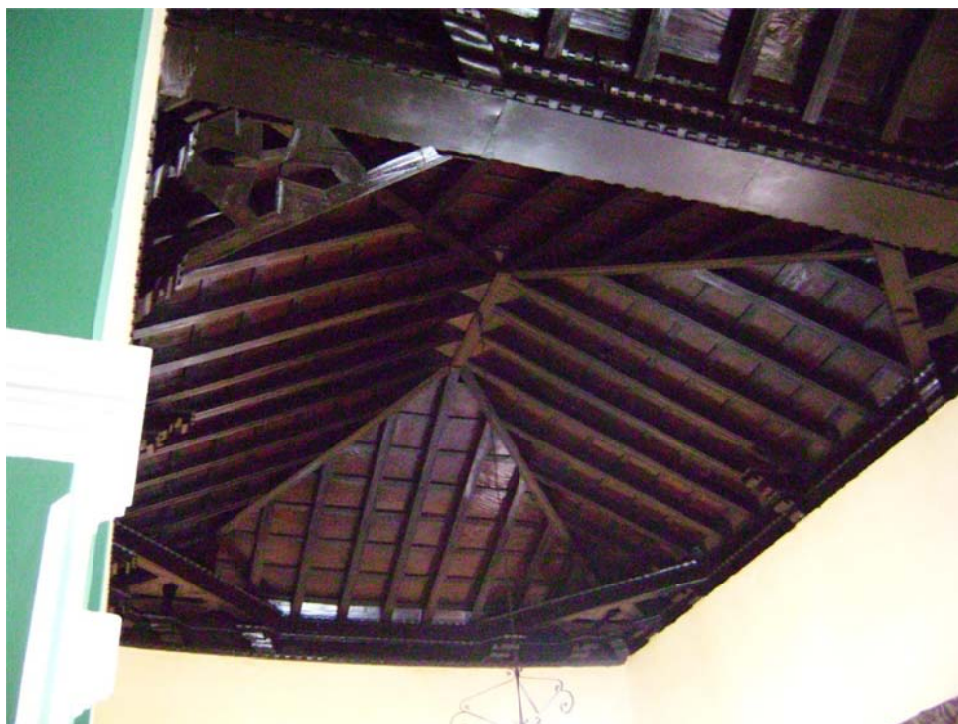
Techo de Armadura tipo Par y Nudillo Restaurante "La Volanta"
