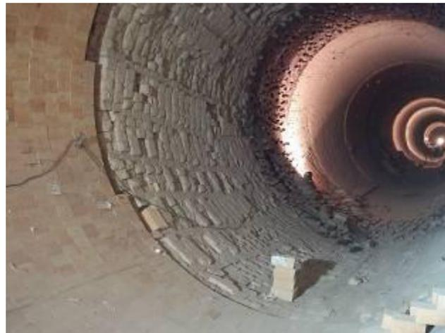
*Revestimiento interno de ladrillos refractarios*
