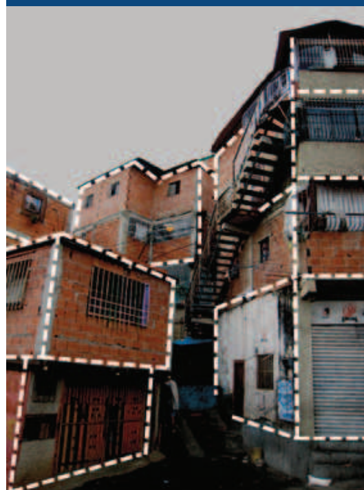
FIGURA 3 Unidades habitacionales improvisadas en un asentamiento informal en Caracas, Venezuela
